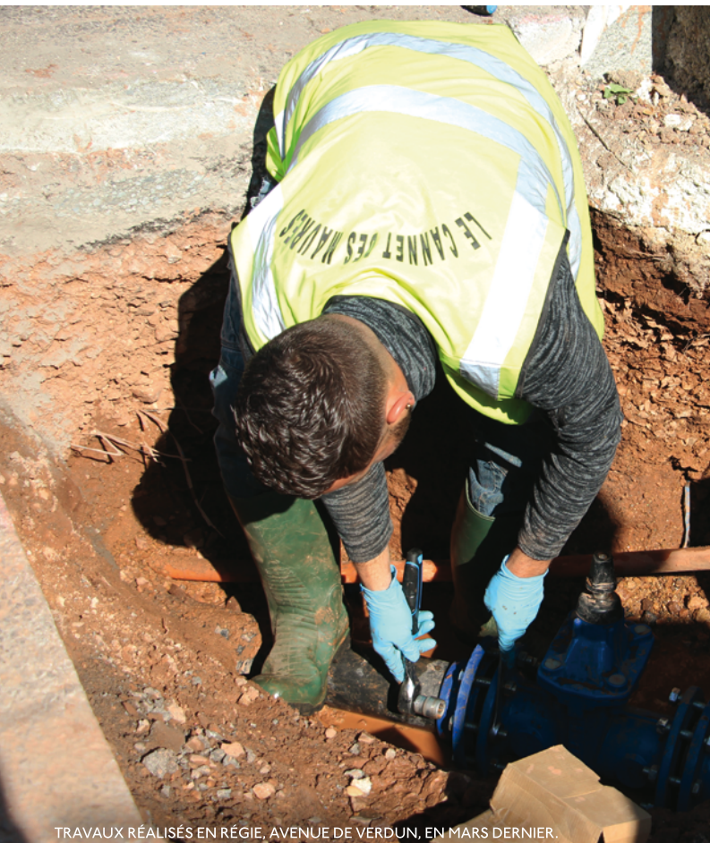
TRAVAUX RÉALISÉS EN RÉGIE, AVENUE DE VERDUN, EN MARS DERNIER.
