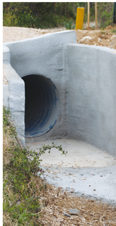
REDIMENSIONNEMENT DE LA TRAVERSÉE PLUVIALE DU CAMP REDON, SUR LA ROUTE DU THORONET, EN MARS 2019.
