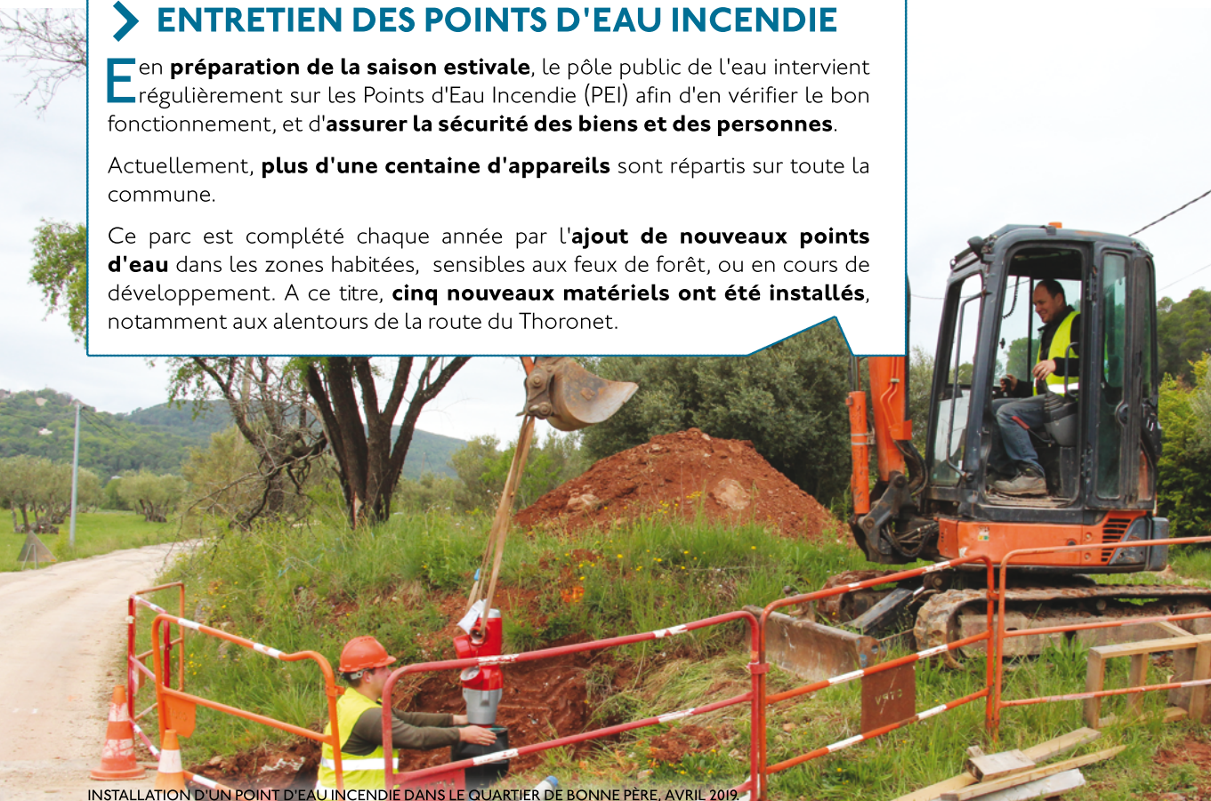
INSTALLATION D'UN POINT D'EAU INCENDIE DANS LE QUARTIER DE BONNE PÈRE, AVRIL 2019.
