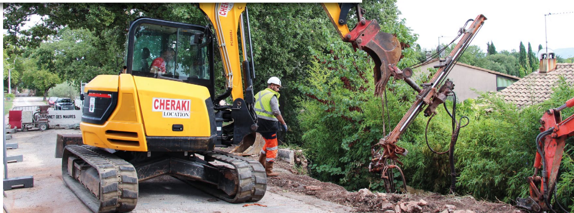
TRAVAUX EN COURS POUR LA RECONSTRUCTION DU MUR DE SOUTÈNEMENT DU BOUILLIDOU, ÉCROULÉ LORS DES DERNIÈRES INONDATIONS QUI ONT TOUCHÉ LA VILLE.
