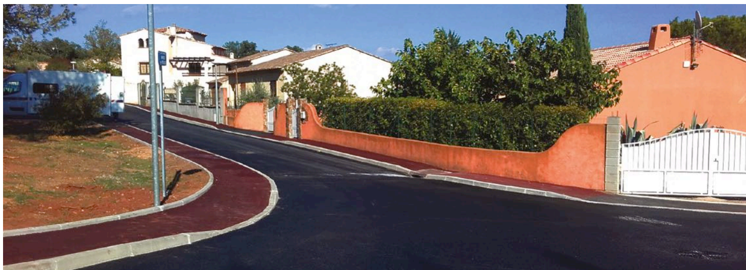
Travaux de voirie - rue de l'Argelas
