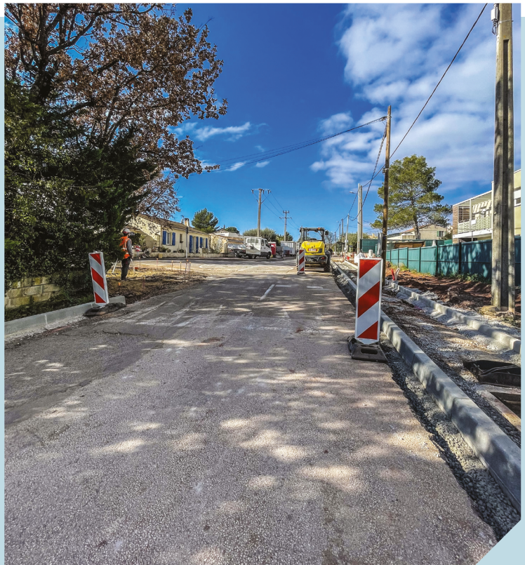
TRAVAUX CHEMIN DU BOUILLIDOU. FÉVRIER 2023.
