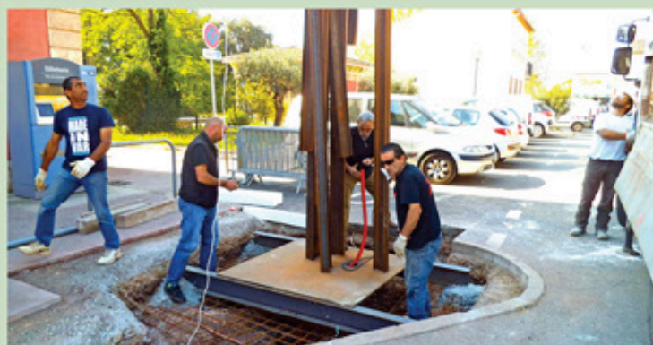
Travaux d'installation de la sculpture Jean-Pierre RIVES
