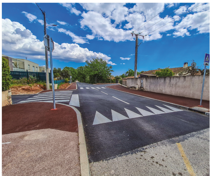
CARREFOUR RÉAMÉNAGÉ CHEMIN DU BOUILLIDOU
