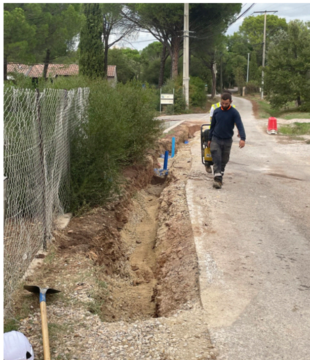
TRAVAUX CHEMIN DES PETUGUES, OCTOBRE 2023.
