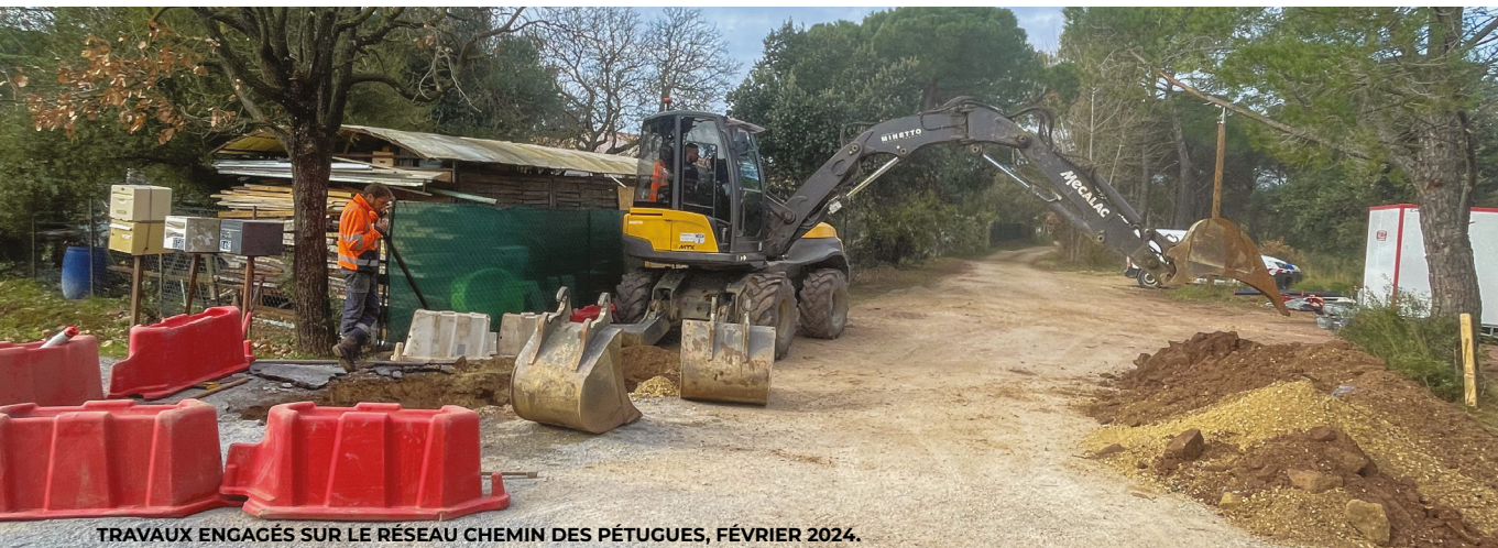
TRAVAUX ENGAGÉS SUR LE RÉSEAU CHEMIN DES PÉTUGUES, FÉVRIER 2024.
