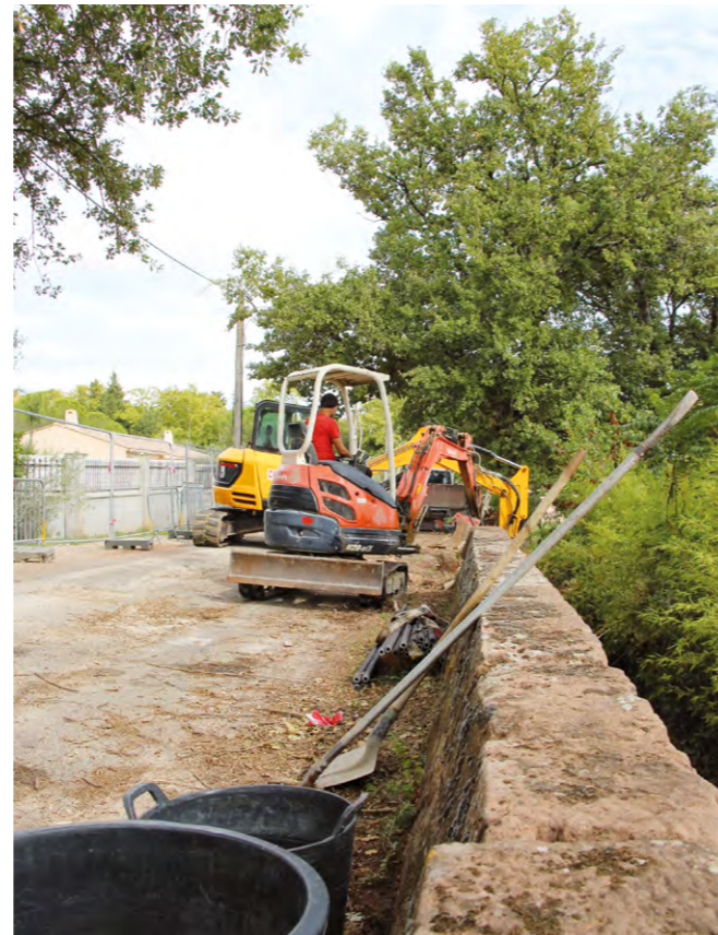
Mur soutainement Bouillidou • Septembre 2021
