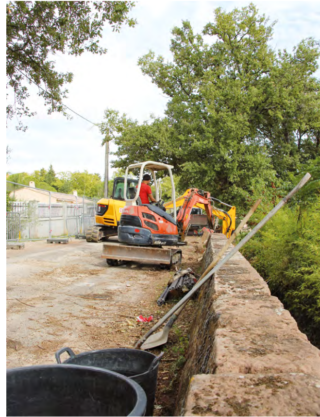
Mur soutainement Bouillidou • Septembre 2021
